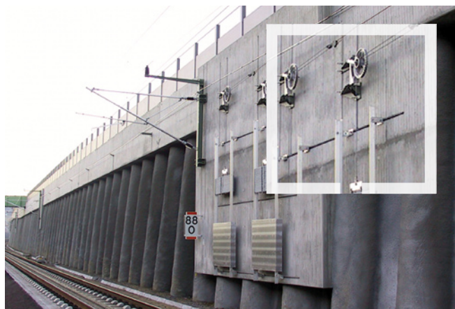
Тоннельное строительство: Крепление натяжных устройств контактной сети
