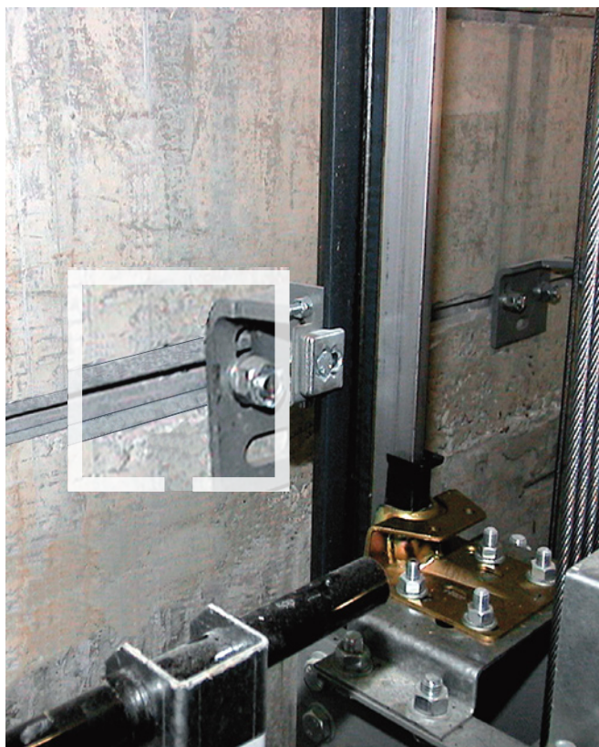
Строительство лифтов: Крепление направляющих
