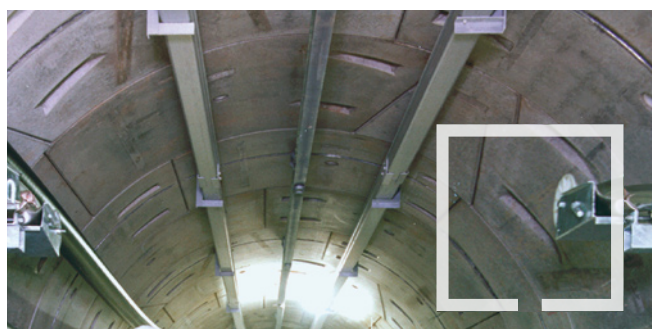
Гнутые шины Halfen в элементах в Тюбингене
