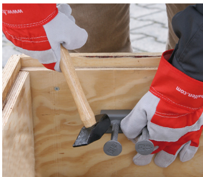
Шины Halfen прибить к опалубке гвоздями
