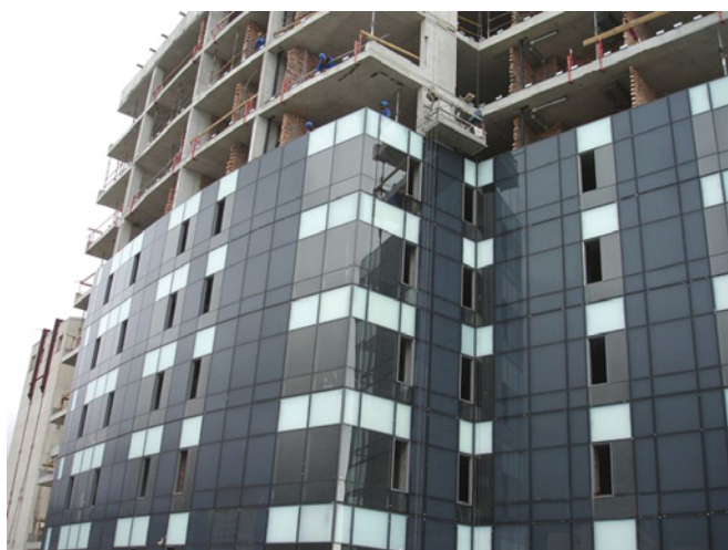
Мандела Родэс проект, Южная Африка: Крепление подвесного фасада (Curtain Wall) с помощью зажимов HCW-B2 на анкерных шинах НТА.
