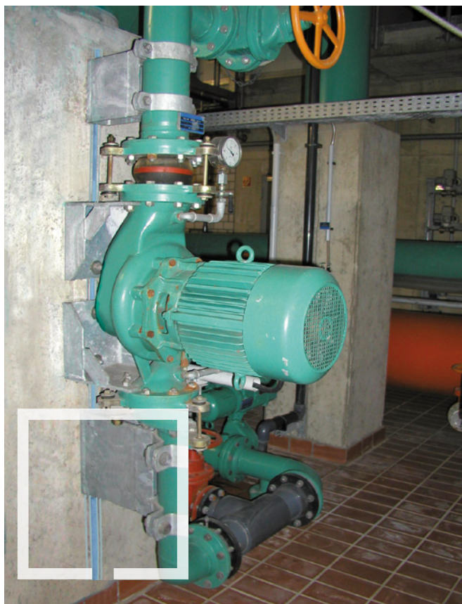
Крепление водопровода
