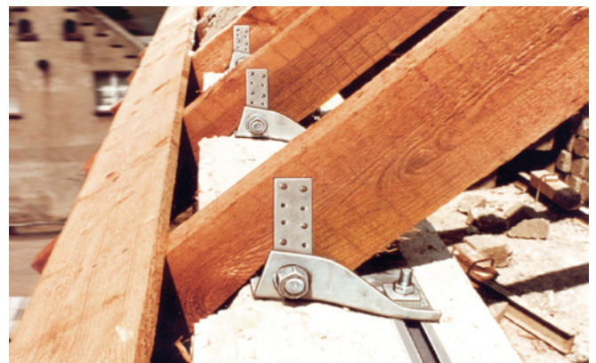
Стропильные основания HALFEN тип HSF 6/12
